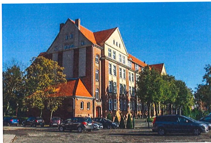
Zdj. nr 11. Budynek Zespołu Szkół Zawodowych nr 2 we Wrześni
