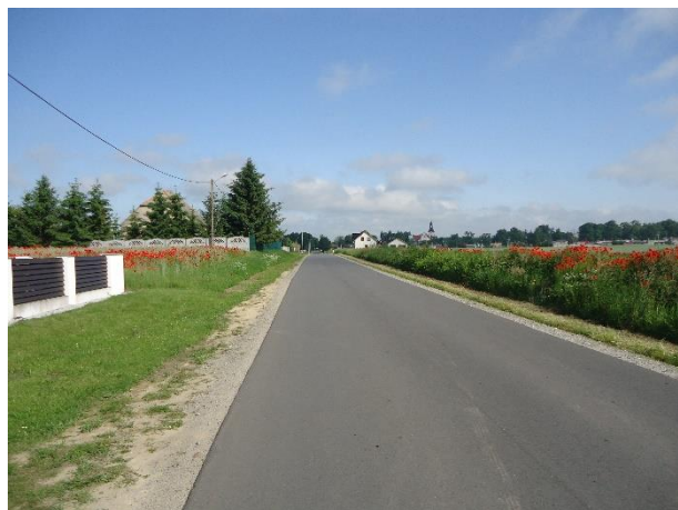
Przebudowa drogi powiatowej nr 2922P na odcinku Sokolniki - Szamarzewo
