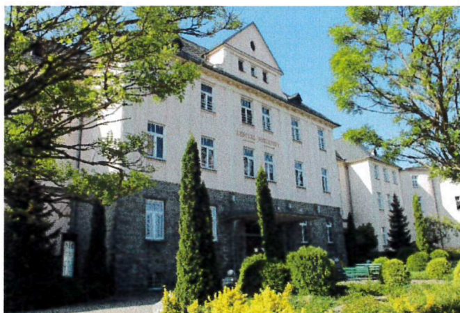
Zdj. nr 12. Budynek starej części szpitala powiatowego we Wrześni
