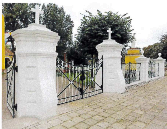
Zdj. nr 17. Prace przy zabytkowym ogrodzeniu kościoła pw. św. Andrzeja Apostoła w Nekli – wykonanie uzupełnień murarskich i malarskich ogrodzenia.
