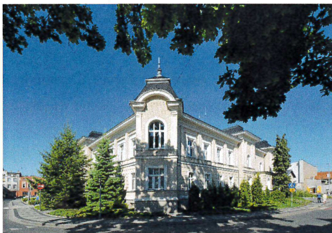
Zdj. nr 9. Budynek Starostwa Powiatowego we Wrześni
