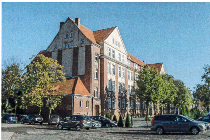
Zdj. nr 13. Budynek Zespołu Szkół Zawodowych nr 2 we Wrześni
