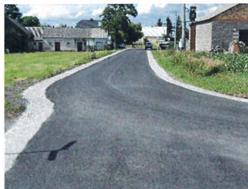
Przebudowa odcinka drogi powiatowej nr 2911P w m. Budziłowo
