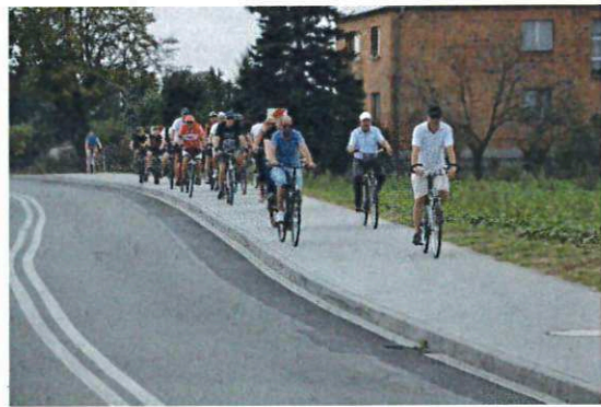
Przebudowa drogi powiatowej nr 2162P na odcinku Gutowo Małe-Grzybowo – budowa ciągu pieszo-rowerowego
