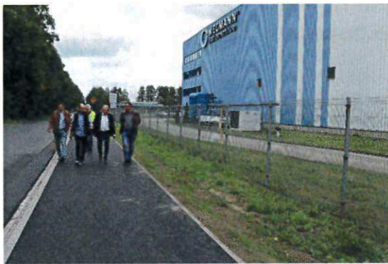
Przebudowa drogi powiatowej nr 2153P – budowa ciągu pieszo-rowerowego w miejscowości Nekla
