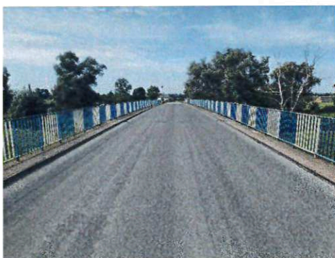
Przebudowa nawierzchni mostu w m. Lisewo
