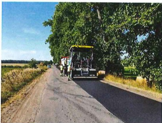
Przebudowa drogi powiatowej nr 2908P w m. Mikuszewo
