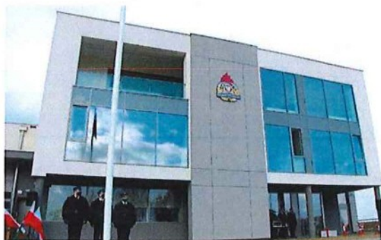
Otwarcie nowego budynku strażnicy
