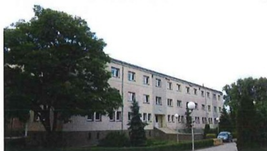
Budynek bursy przy ul. Kaliskiej 2a
