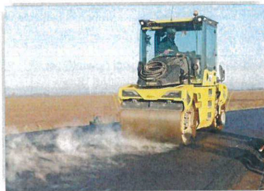
Przebudowa drogi powiatowej nr 2926P Gozdowo-Nowa Wieś Królewska
