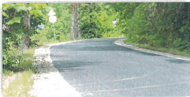
Modernizacja drogi powiatowej nr 2908P Sarnice-Mikuszewo
