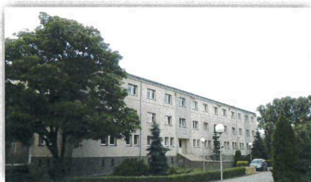
Budynek bursy przy ul. Kaliskiej 2a
