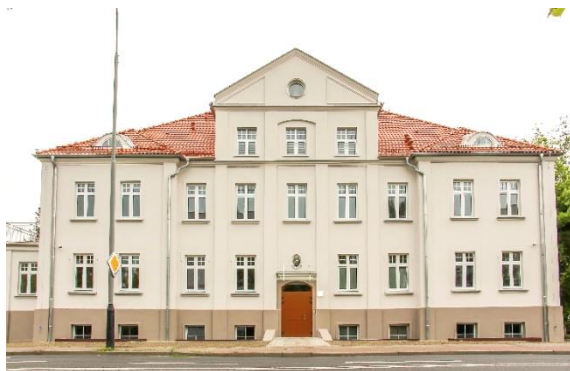
Budynek bursy przy ul. Słowackiego 11
