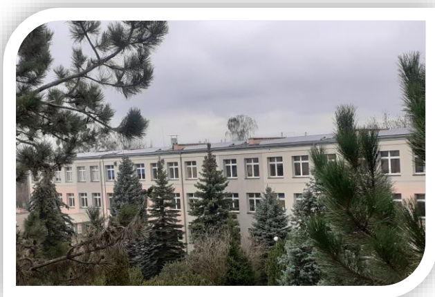
Instalacja fotowoltaiczna na budynku ZSTiO
