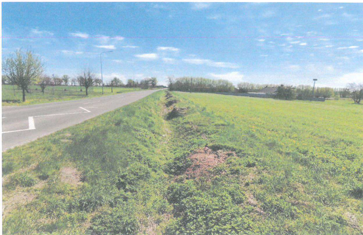
Zdj. 3 Obecny stan drogi
