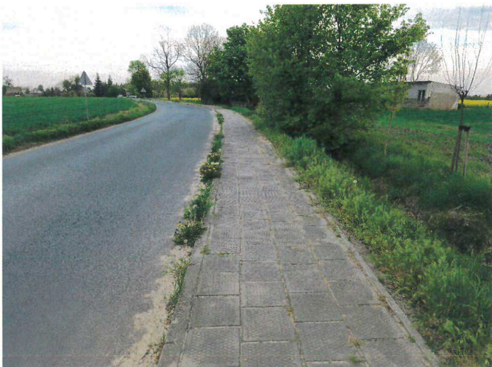
Zdj. 5. Obecny stan chodnika
