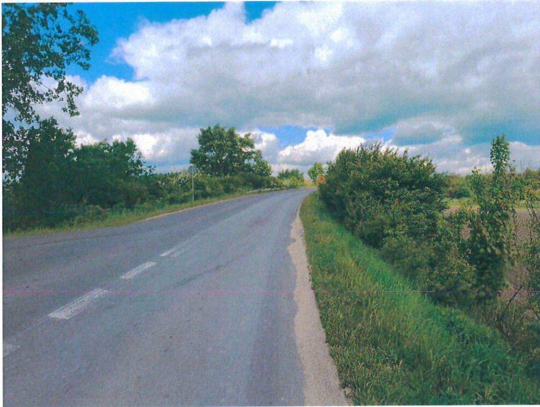
Zdj. 5. Obecny stan wiaduktu
