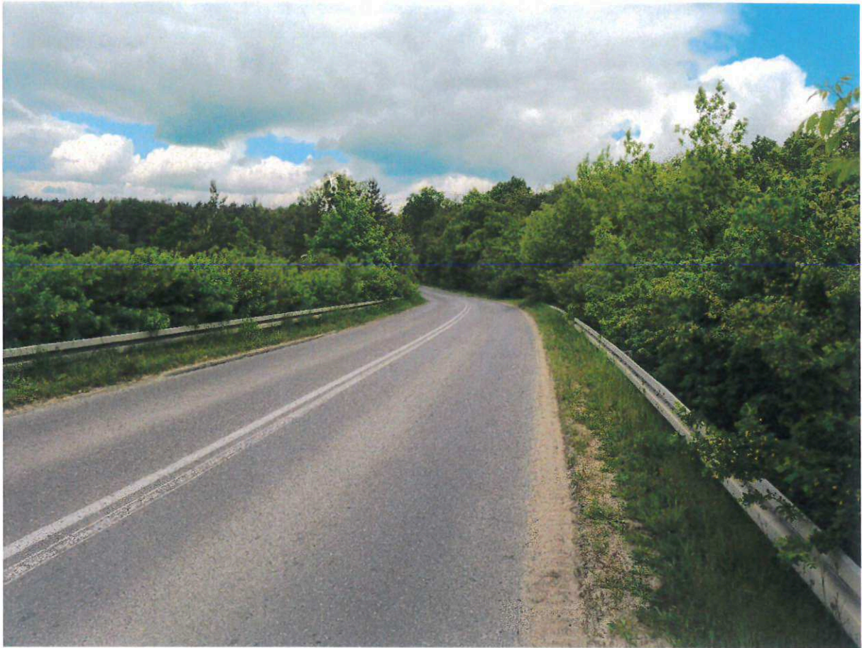
Zdj. 2. Obecny stan wiaduktu
