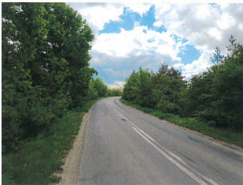
Zdj. 11. Obecny stan wiaduktu
