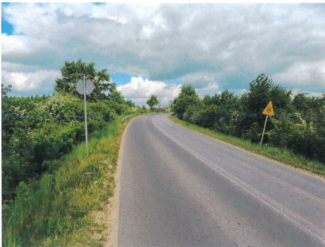
Zdj. 7. Obecny stan wiaduktu
