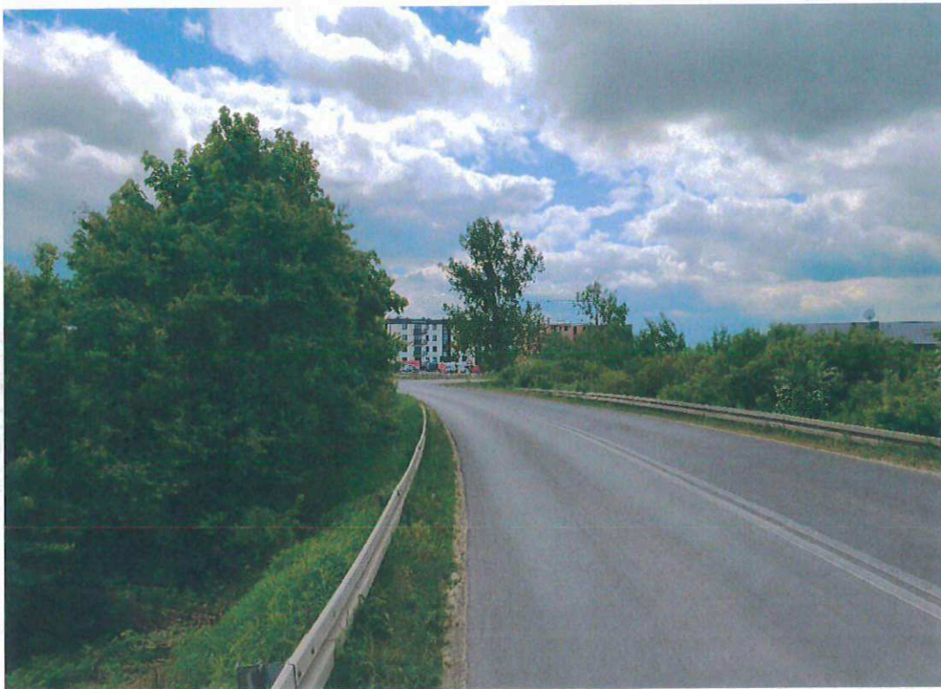
Zdj. 6. Obecny stan wiaduktu
