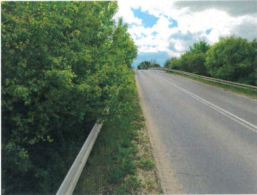
Zdj. 15. Obecny stan wiaduktu
