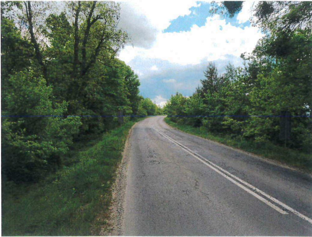
Zdj. 13. Obecny stan wiaduktu
