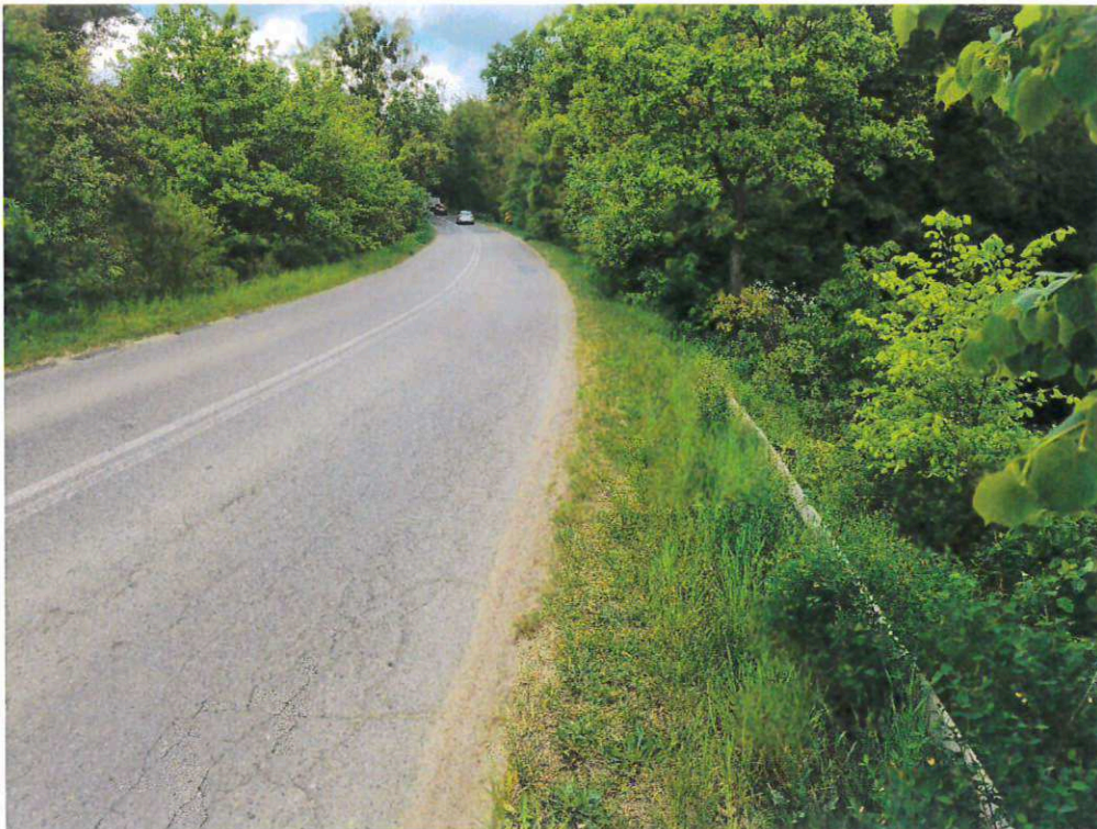
Zdj. 14. Obecny stan wiaduktu
