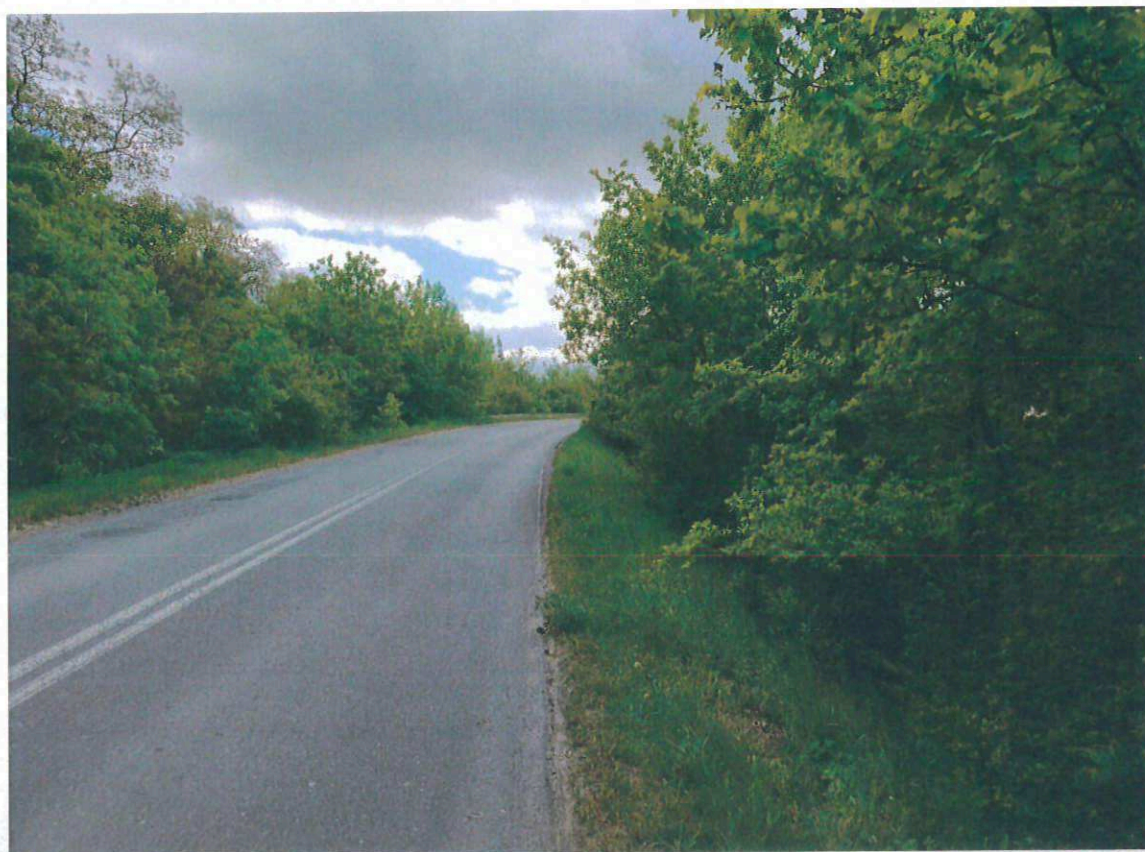
Zdj. 1. Obecny stan wiaduktu
