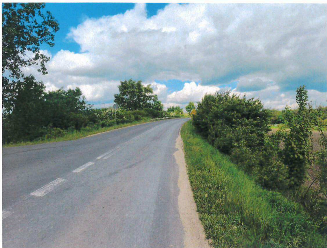
Zdj. 8. Obecny stan wiaduktu
