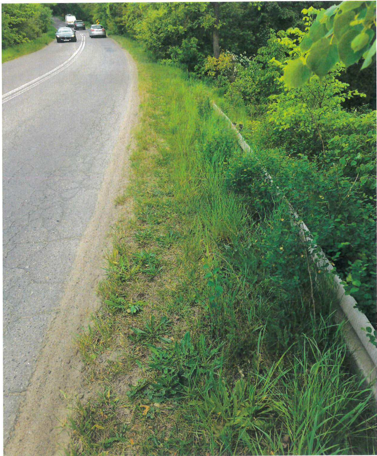
Zdj. 12. Obecny stan wiaduktu
